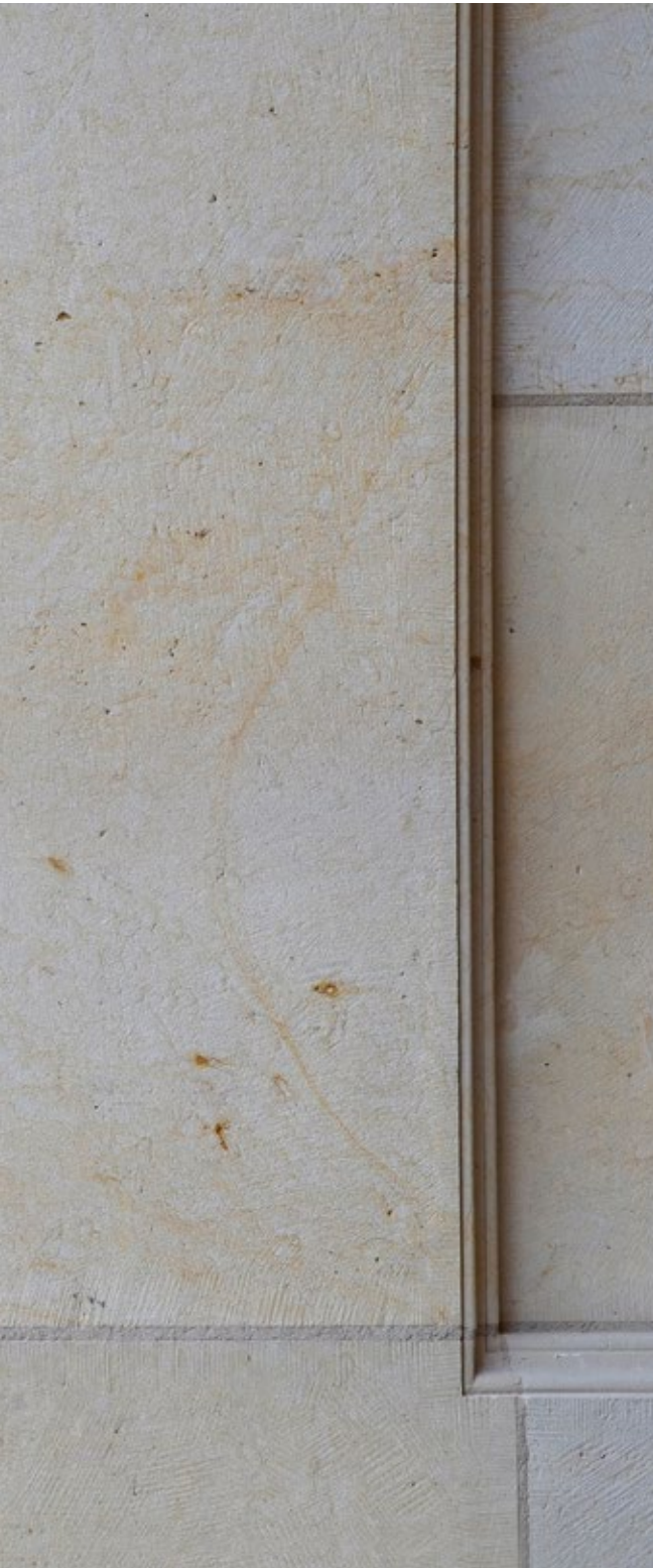
Abb. 6 (links) Oberfläche der Architekturbetonelemente. Bewusst wurde eine Optik steinmetzmäßig bearbeiteter Natursteine angestrebt
